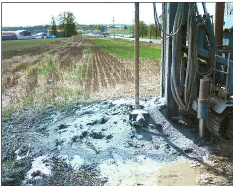
Slika 1: Izvedba raziskovalne vrtine SL-1/11
