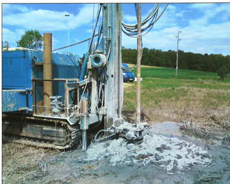
Slika 3: Izvedba raziskovalne vrtine SL-1/11
